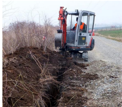
Prace ziemne z użyciem mikrokoparki
