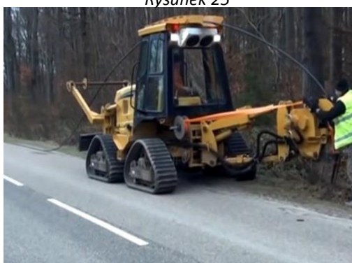
Prace ziemne z użyciem pługokładacza
