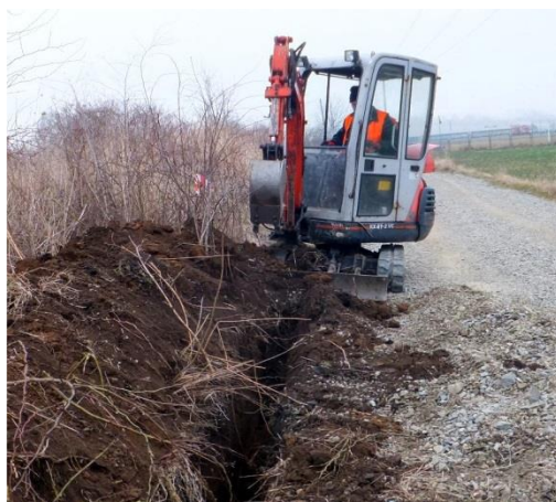
Prace ziemne z użyciem mikrokoparki
